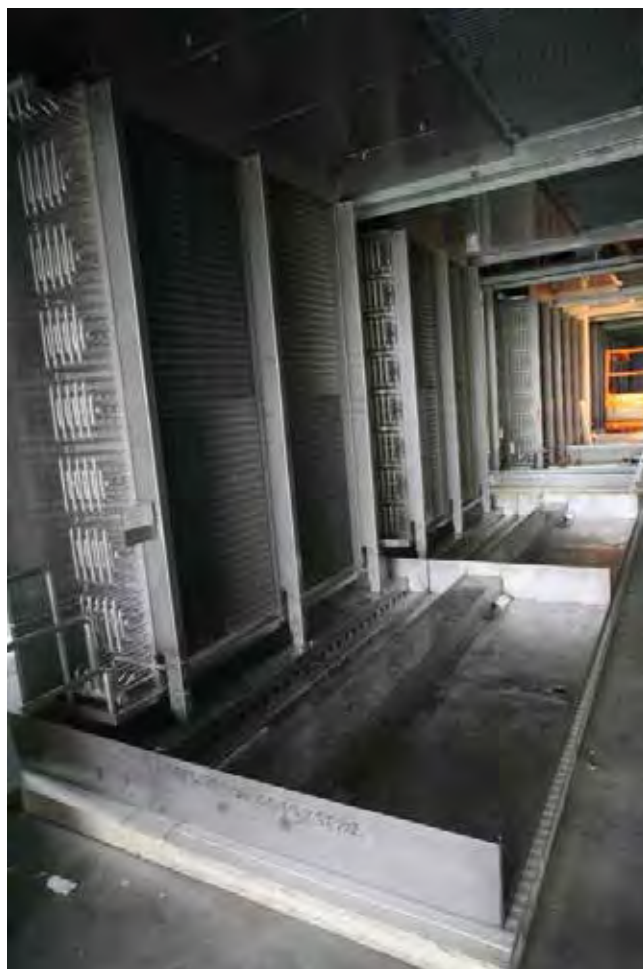
Obr. 2 – Z montáže výparníků
