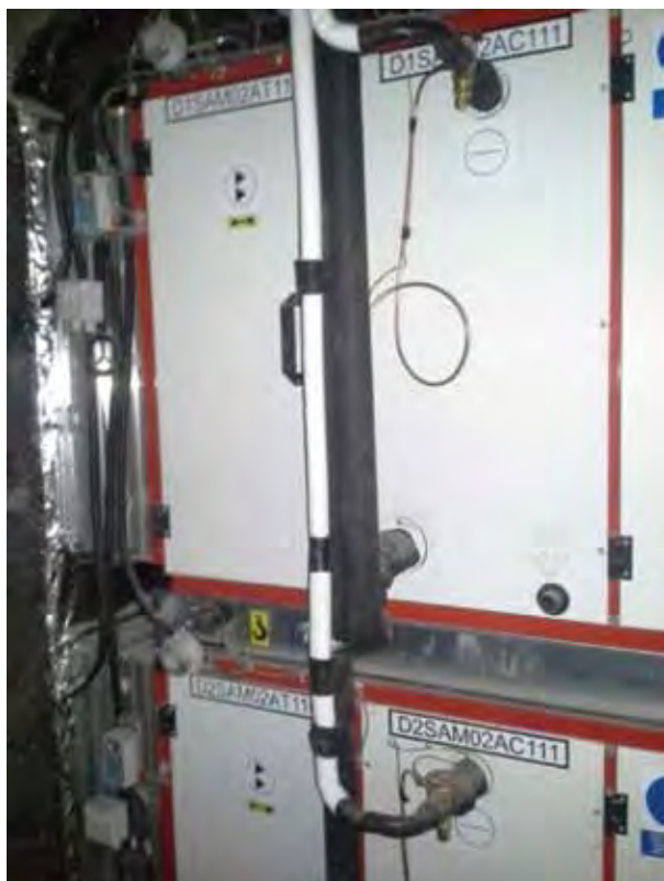
Obr. 3 - Napojení potrubí chladiva do klimajednotky
