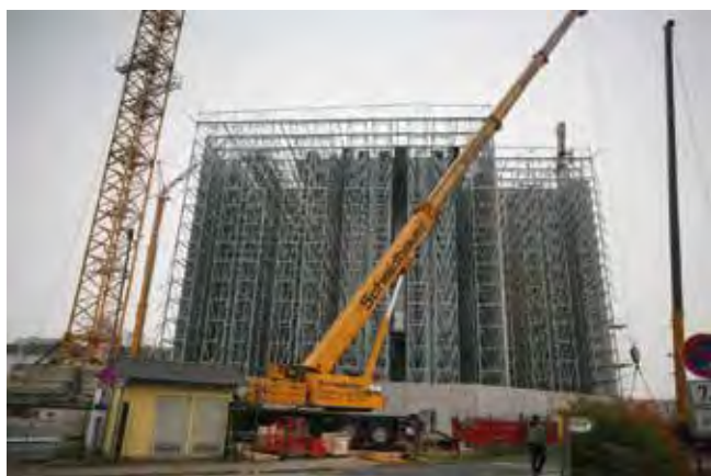
Obr. 1 – Ze stavby skladovacího areálu
