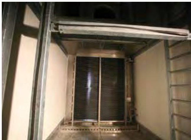
Obr. 3 – Z montáže komory chlazení
