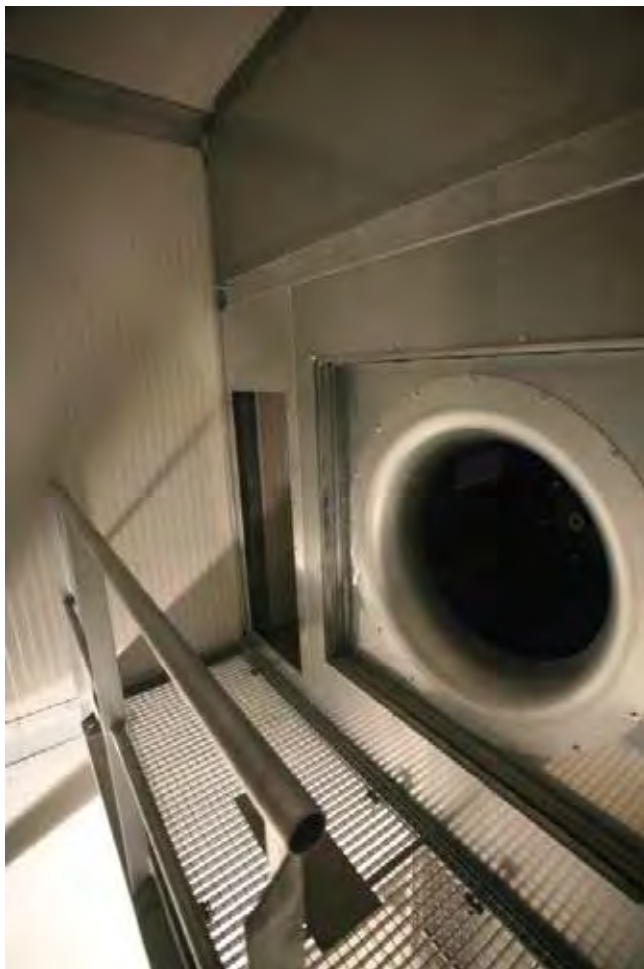
Obr. 4 – Z montáže komory ventilátoru
