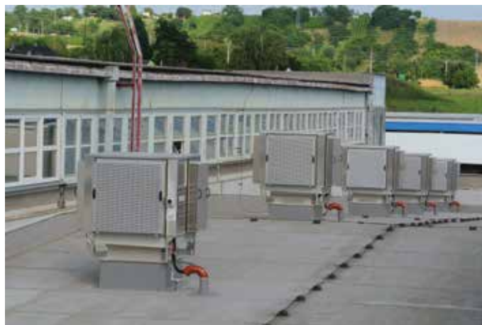
Obr. 4 - Adiabatický chladicí systém CoolStream je navržen modulárně a je vhodný pro chlazení vysoce tepelně zatížených hal stejně dobře jako menších provozů
