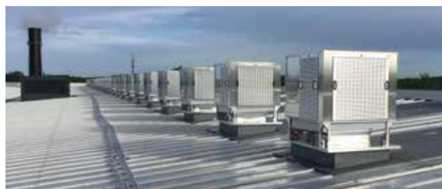
Obr 4 - Adiabatický chladicí systém CoolStream je navržen modulárně a je vhodný pro chlazení vysoce tepelně zatížených hal stejně dobře jako menších provozů.
