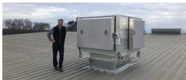
Obr 4 - Adiabatický chladicí systém CoolStream je navržen modulárně a je vhodný pro chlazení vysoce tepelně zatížených hal stejně dobře jako menších provozů.
