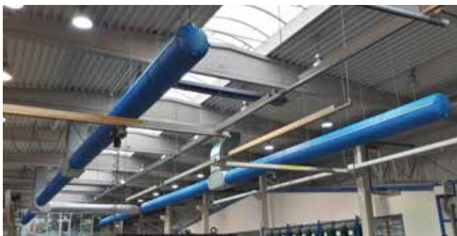
Obr. 3 – Vhodné umístění jednotek CoolStream, krátká přívodní potrubí a účinná, ohleduplná a komfortní distribuce je nedílnou a významnou součástí adiabatického chlazení
