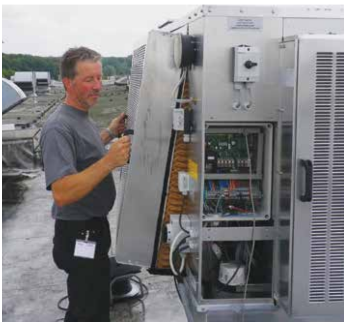
Obr. 4 – Snadné vyjímání bočních panelů vytváří optimální servisní přístup do jednotek CoolStream
