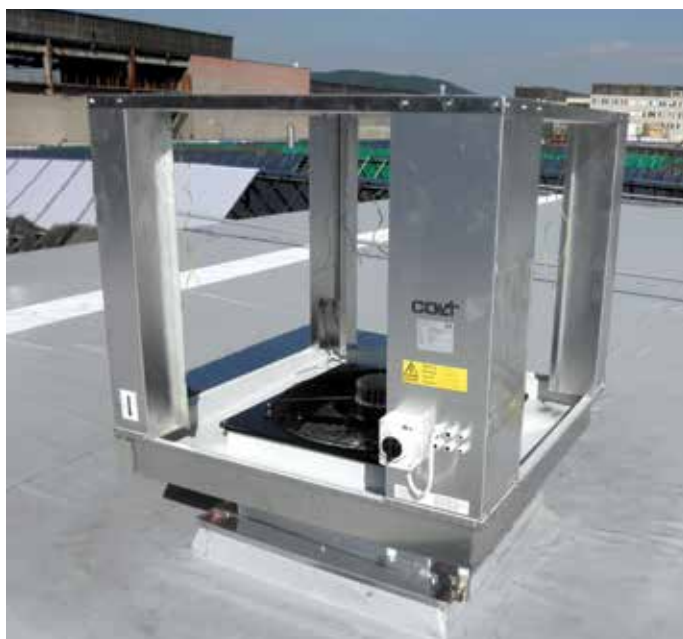
Obr. 4 – Snadné vyjímání bočních panelů vytváří optimální servisní přístup do jednotek CoolStream
