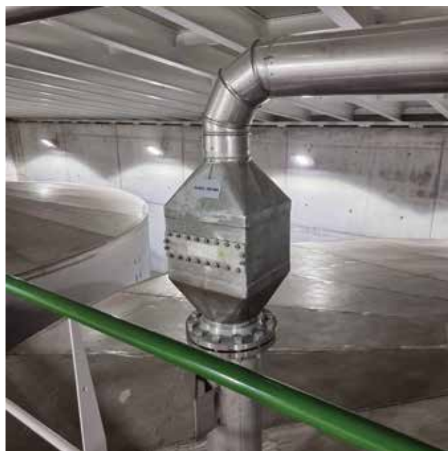
Obr. 6 – Filtr / Odlučovač výparů s gravitačním odtokem kondenzátu zpět do nádrže umístěný na odvodu zásobníku s chemickými látkami
