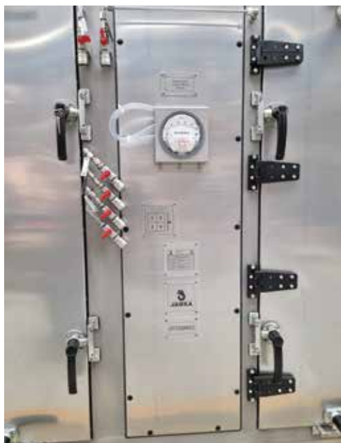
Obr. 5 – Měření tlakové difference, měření těsnosti uložení filtrů
