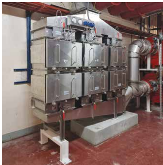
Obr. 8 – Filtrační zařízení s dvoustupňovou filtrací v celo-nerezovém plynotěsném provedení s bezkontaktní výměnou filtrů
