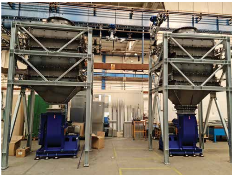
Obr. 8 – Parní ohřívač vzduchu v provedení celého technologického uzlu včetně příslušenství na klíč
