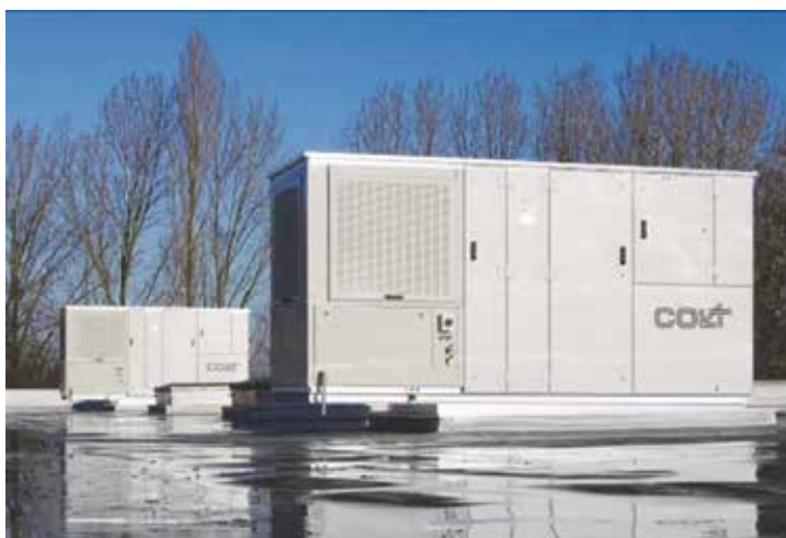
Obr. 7, 8 – Vzduchotechnické vlastnosti adiabatického chlazení CoolStream lze rozšířit využitím rooftopů CoolStream T a R (chlazení, větrání, směřování, dohřívání) s integrovanou adiabatickou chladicí komorou
