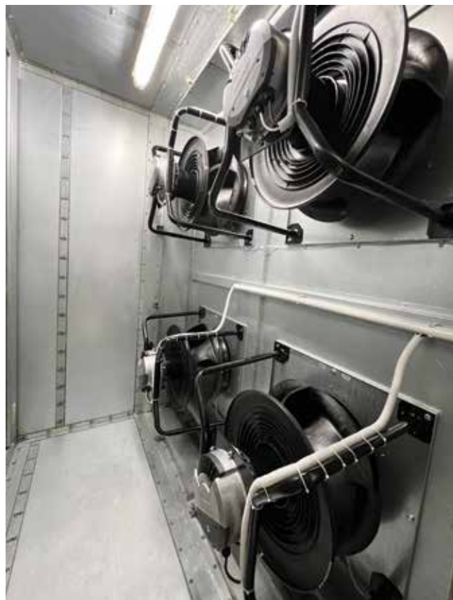
Obr. 7 – Modernizace vzduchotechnických jednotek jiného výrobce
