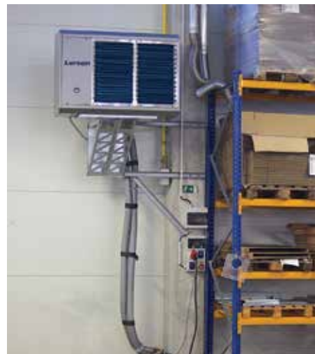
Obr. 5 – Instalace vnitřní jednotky ZETA TC
