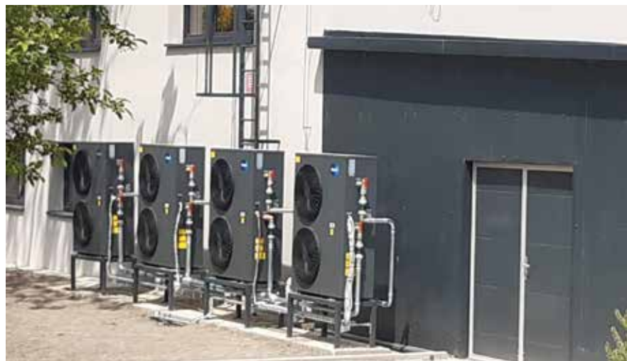
Obr. 1 – Kaskáda čtyř tepelných čerpadel FEIHCD100S3
