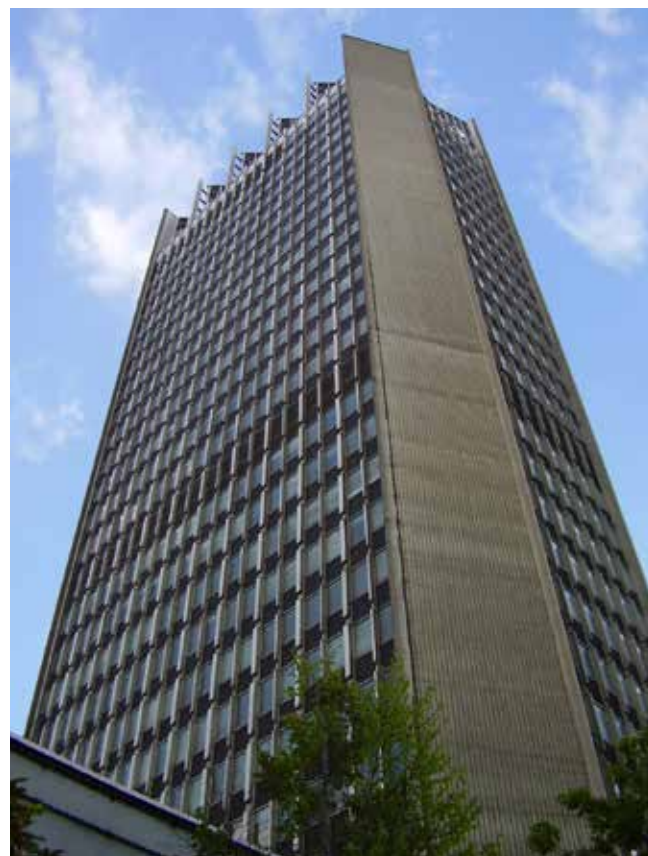
Obr. 1 – Budova Slovenské televize je výšková budova v bratislavské lokalitě Mlynská dolina. Původně sloužila pro potřeby Československé a později Slovenské televize. Byla dostavěna v roce 1975, má 28 pater. Dlouhou dobu se jednalo o nejvyšší budovu na Slovensku i v celém bývalém Československu a v rámci Slovenska ji překonala až budova Národní banky Slovenska v roce 2002. V současnosti je část budovy opuštěná a hledá se pro ni nové využití. (wikipedia.org, foto: Wizzard – vlastní dílo, CC BY-SA 3.0, https://commons.wikimedia.org/w/index.php?curid=858286 )
