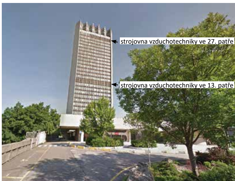
Obr. 7 – Budova má 29. podlaží. Strojovny vzduchotechniky jsou situovány na 13. a 27. podlaží.
