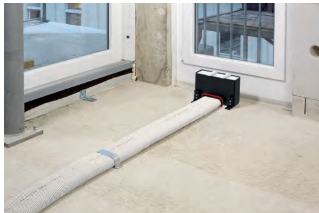
Obr. 3 – Ploché potrubí se uplatní tam, kde je na kulaté potrubí málo místa
