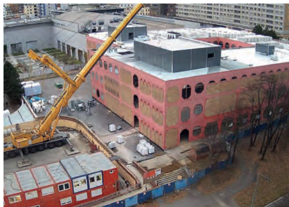
Obr. 5 – a) Chladicí věž typu TES s radiálními ventilátory na střeše obchodního domu b) střecha při rekonstrukci
