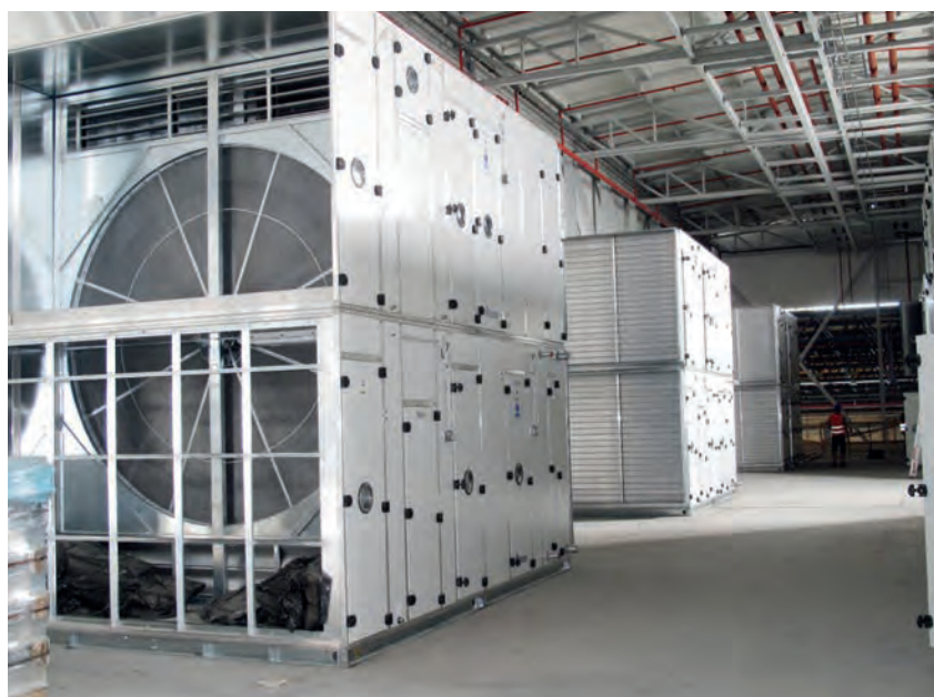
Obr. 3 – Vzduchotechnické jednotky JANKA Radotín v průmyslovém provozu
