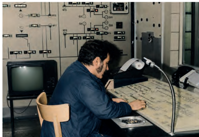
Obr. 4 – Dispečerské stanoviště na velínu s ovládacím pultem s prvky MOZAICA
