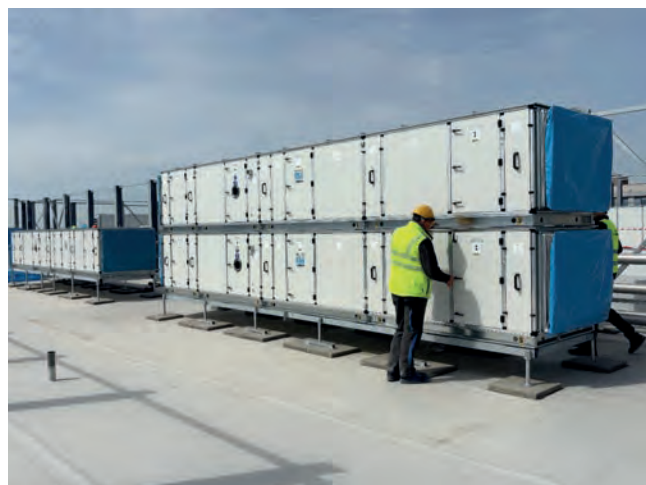
Obr. 2 – Modulární VZT jednotka
