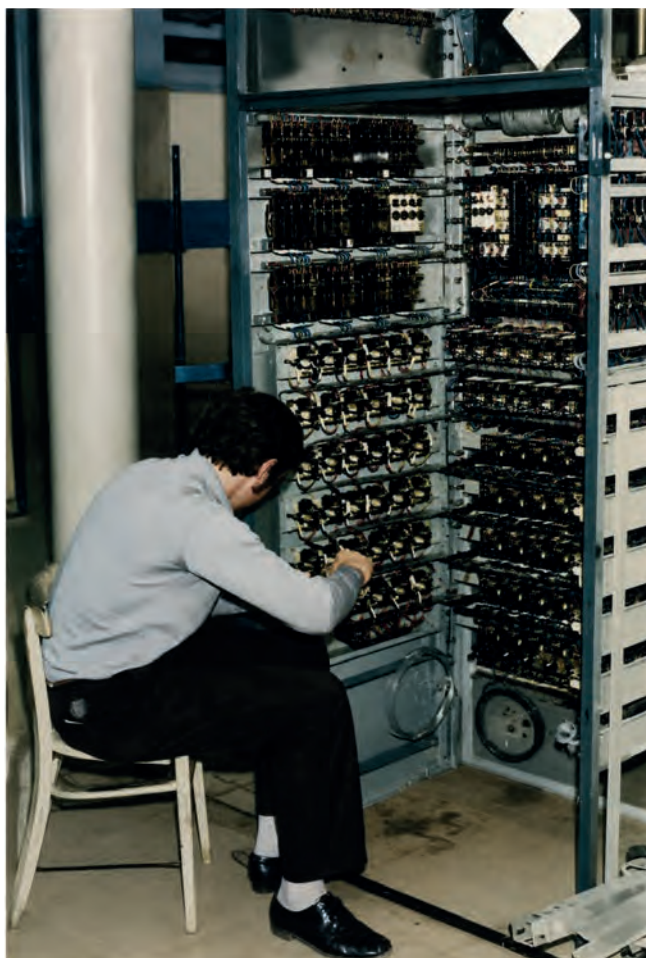
Obr. 5 – Montážní práce na rozvaděči
