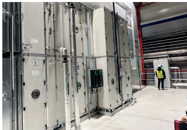
Obr. 5 – VZT jednotka JANKA Radotín v průmyslovém provozu
